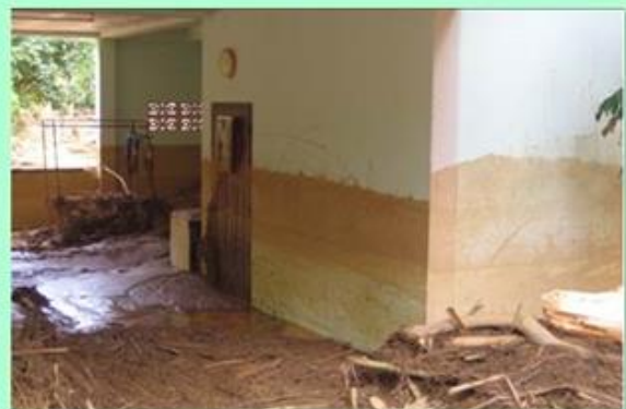
ภาพถ่ายจากพื้นที่ตำบลบ้านพูนหลังเหตุการณ์ฯ แสดงลักษณะของสภาพการ ตกค้างของตะกอนซากต้นไม้ ตะกอนหิน ดิน และโคลน รวมทั้งร่องรอยของการ กัดเซาะพังทลายของพื้นที่ริมตลิ่งอย่างรุนแรง รวมทั้งสภาพของบ้านเรือนที่พัง และถูกทับถมด้วยตะกอนชนิดต่างๆ ที่ถูกกระทำจากการ กระบวนการ ดินถล่ม (Landslides) ประเภท "น้ำปนตะกอนท่วมป่า (Debris flood)" ที่ยังคงทิ้งร่องรอย
